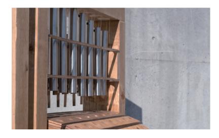
主にステンレスパイプと木材 で作られており、ピンを挿し た際に、パーツが落ちずにき ちんと固定されるよう、穴の 一つ一つに強力磁石を埋め込 んでいる。
